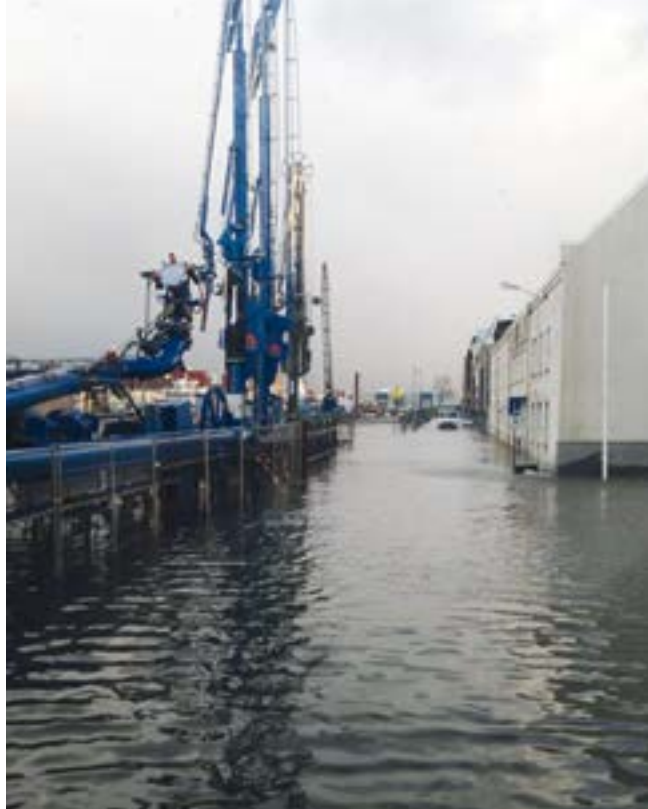
Spring tide at the Waterleidingstraat site.
