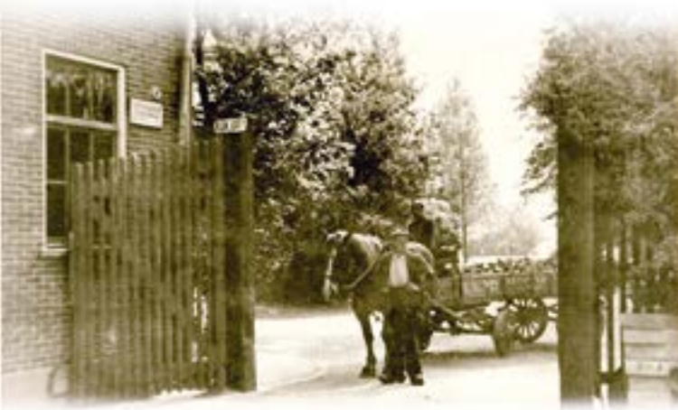
Hoflaan municipal works, 1930. Standing Dirk van Everdinge and carter Kees Kattestaart on the trestle.
